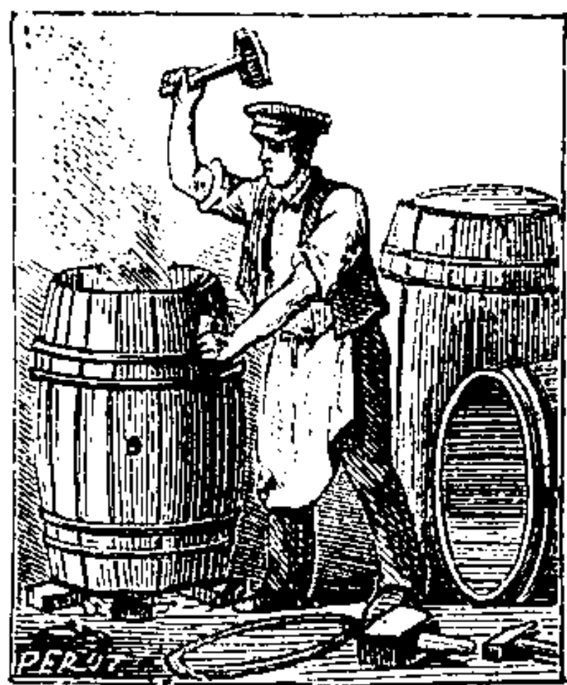
LE TONNELIER. — Pour rendre plus flexibles les douves qu'il veut recourber et assembler, le tonnelier allume dessous un feu de copeaux. Ensuite il les entoure de cercles en bois ou en fer.
