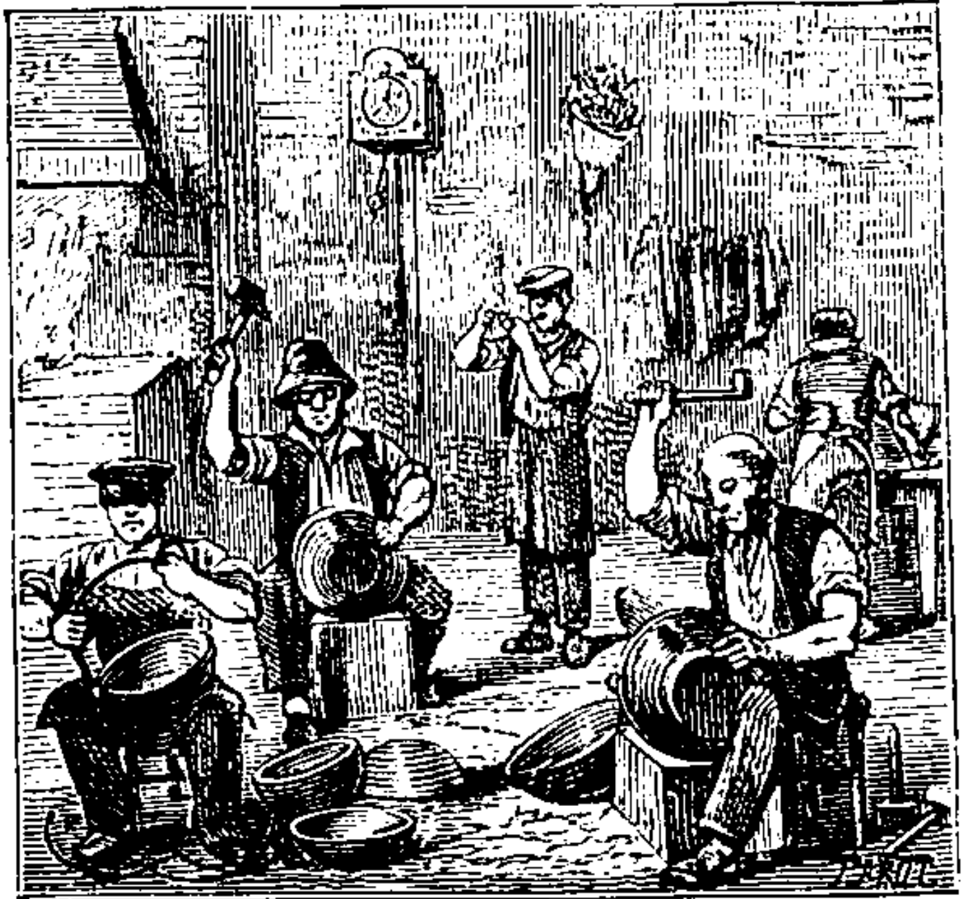
CHAUDRONNIERS D'AURILLAC. — La chaudronnerie est l'art de fabriquer tous les ustensiles en métal qui servent à faire chauffer l'eau et les aliments. La petite chaudronnerie fabrique les chaudrons de cuisine, les casseroles, les poêlons, etc. La grosse chaudronnerie fabrique les énormes chaudières des locomotives ou des bateaux à vapeur, les cuves des teinturiers, etc. L'Auvergne et la Normandie sont les centres de la chaudronnerie.
