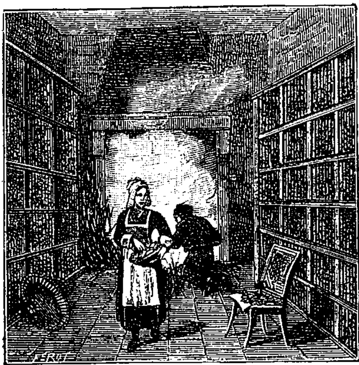
UNE MAGNANERIE DANS LE DAUPHINÉ. — Les magnaneries sont des chambres dans lesquelles on a installé, les unes au-dessus des autres, des claies de roseaux. Les œufs des vers à soie sont placés sur ces claies, et pour qu'ils puissent éclore, on chauffe les chambres. Souvent les magnaneries sont mal tenues et trop petites pour le nombre de vers qu'on y entasse; ce qui a amené dans les dernières années une dégénérescence des vers à soie.
