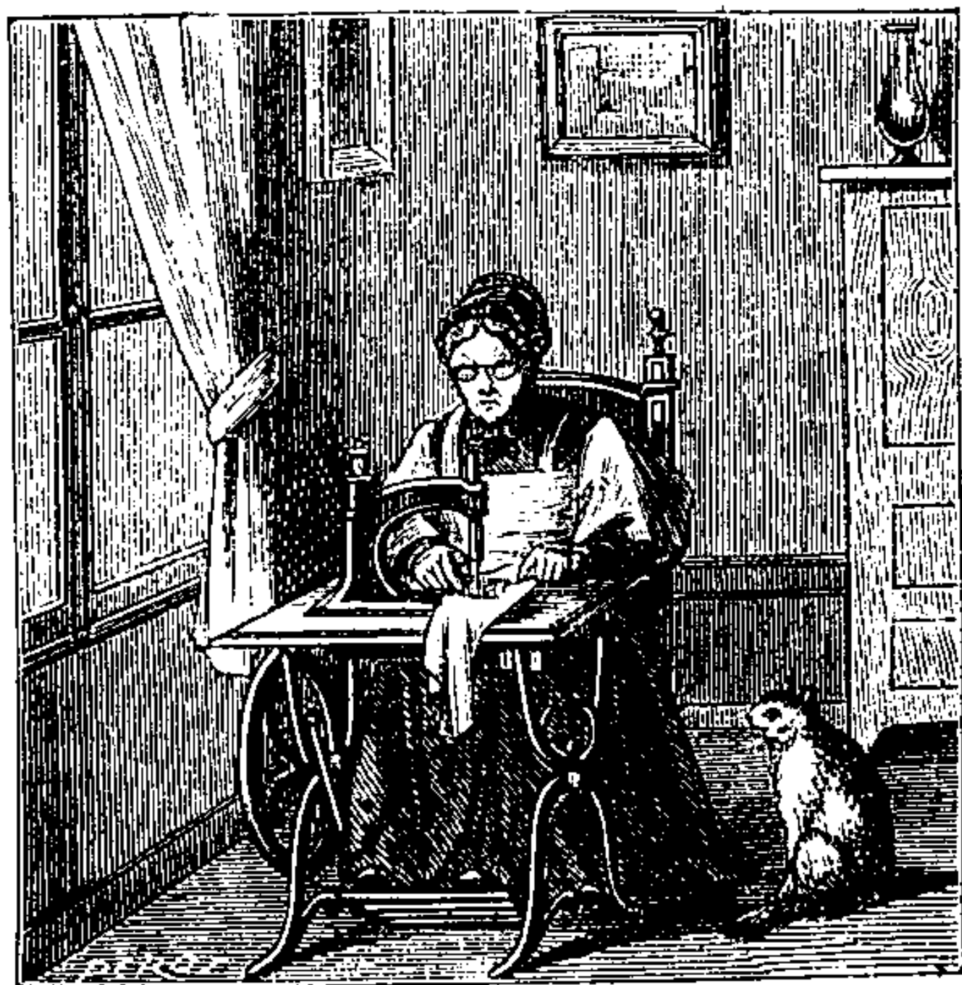
LA MACHINE À COUDRE. — Cette machine si utile et si répandue aujourd'hui, a été inventée il n'y a pas longtemps par l'Américain Elias Howe. On la mène la plupart du temps avec le pied. Elle coud avec rapidité et solidité. Une machine à coudre fait l'ouvrage de deux ouvrières actives.
